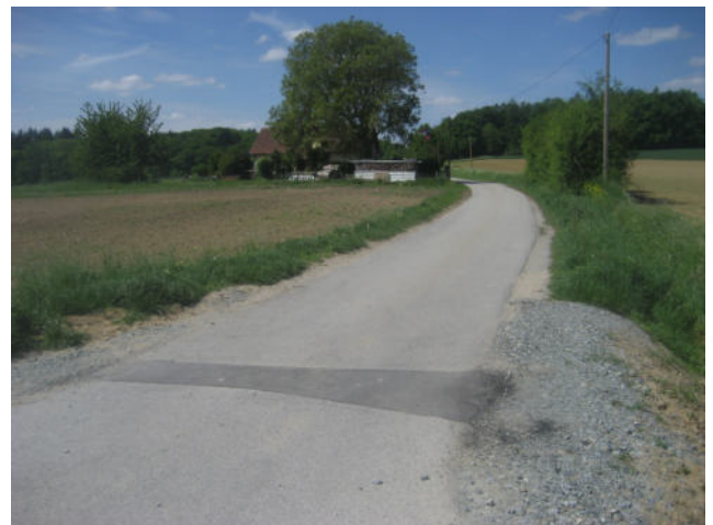
Abb. 5: Blick von NO-Ecke Richtung Westen entlang der Riedstraße, in Hintergrund Anwesen mit Einzelbaum
