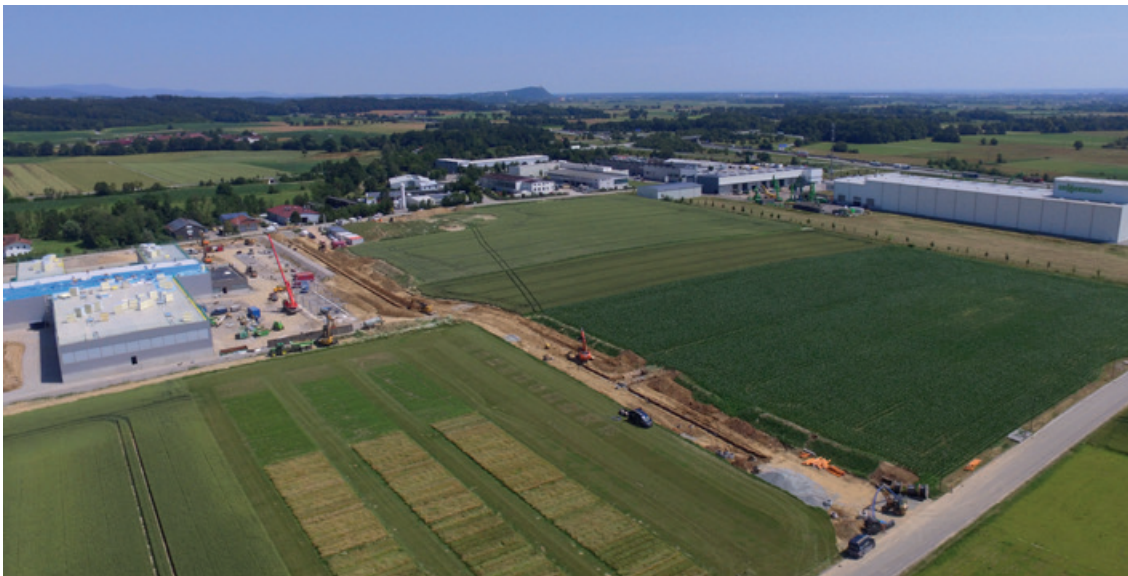
Das Bauvorhaben Trans-o-Flex begann im Dezember 2023 und ist inzwischen ebenfalls fertiggestellt.
