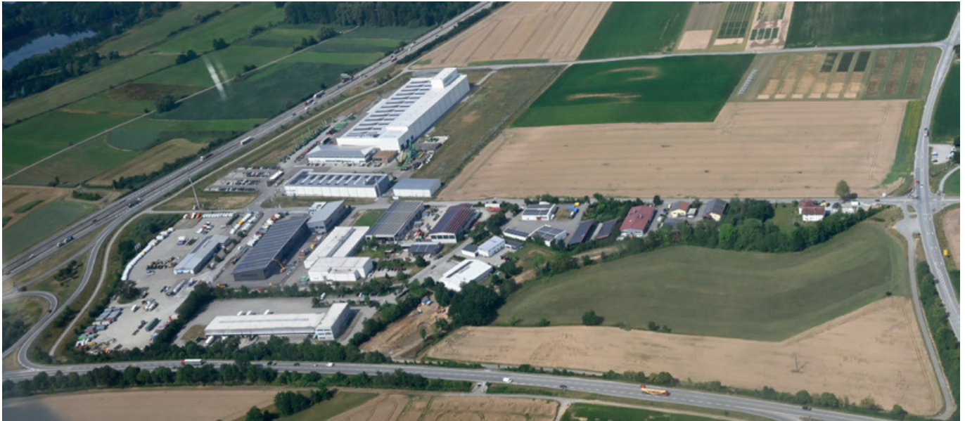
Gewerbegebiet Rotham II/1 und Rotham II/2 Die Firma Sennebogen im Gewerbe- und Industriegebiet Steinach Süd ist ebenfalls bereits vorhanden. aufgenommen im Juli 2023
